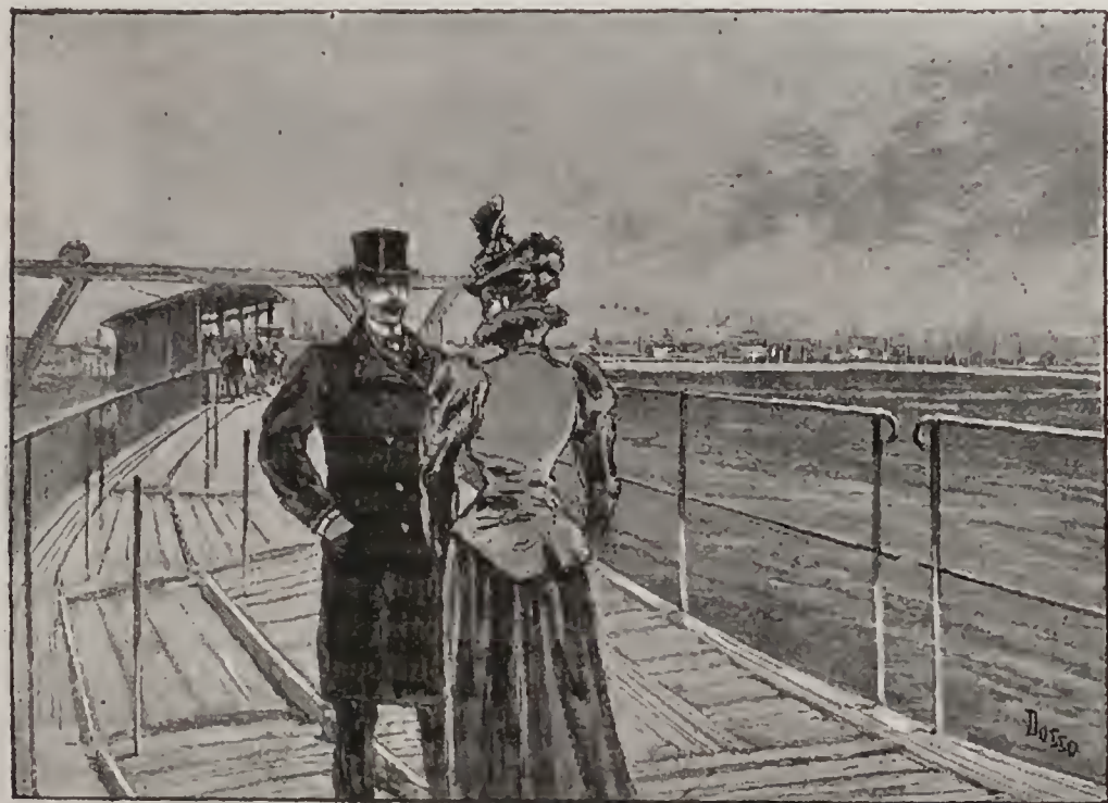
LA PLATE-FORME ÉLECTRIQUE MOBILE. — Près de la tribune d'accès.
